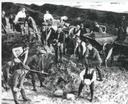
Erdarbeiten 1926 an der AVUS
