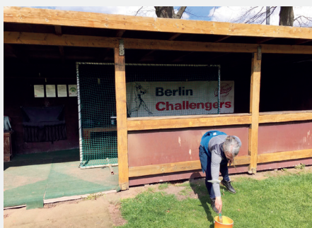
Arbeiten am Dugout: abschleifen und lasieren
